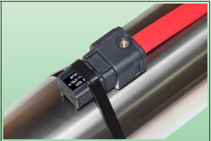
После ввода кабеля - затяжка и монтаж на трубе
